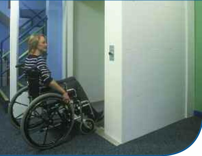
El Vector es una plataforma elevadora vertical, especialmente diseñada para integrarse fácilmente en su edificio. No necesita un foso profundo y, aunque se recomienda que haya una profundidad de 5 cm, es posible instalar una rampa de acceso.
